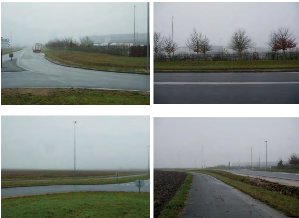
Figure 50 Photographie des abords du site au niveau de la D11
